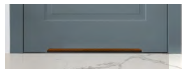
Podcięcie łazienkowe, wys. od podłogi 19 mm
